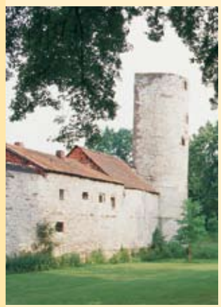
Le mur d'enceinte et la «Tour des cigognes»
